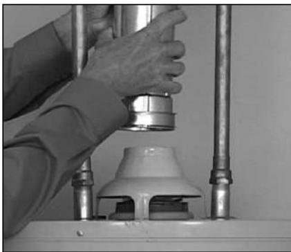
Figure 14 - Détacher le conduit d'évacuation du coupe-tirage.
