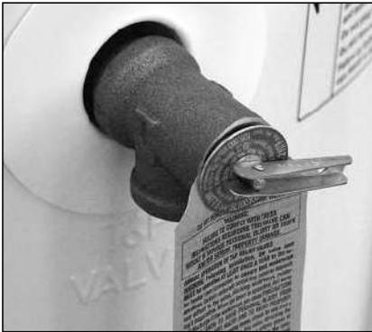
Figure 16 - Soupape de décharge à sécurité thermique
