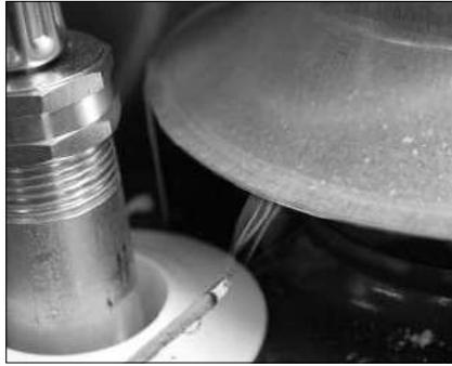
Figure 26 - Contrôler l'alimentation en air et l'évacuation des gaz de combustion du chauffe-eau pour s'assurer qu'elles sont correctes et suffisantes.
