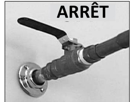
Figure 11 - Arrivée d'eau froide fermée.
