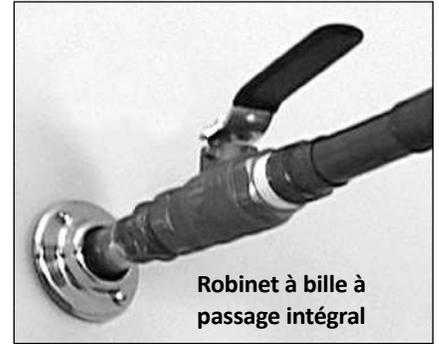
Figure 17 - Ouvrir complètement le robinet d'alimentation d'eau froide.
