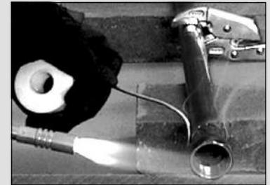
**AVIS :** Ne pas souder les tuyaux tandis qu'ils sont attachés au chauffe-eau. Les connexions d'entrée et de sortie du chauffe-eau contiennent des pièces non métalliques qui pourraient être endommagées. La façon appropriée de connecter le chauffe-eau à des tuyaux d'eau en cuivre est comme suit :
