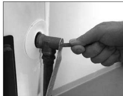
Figure 38 - Soupape de décharge DST
