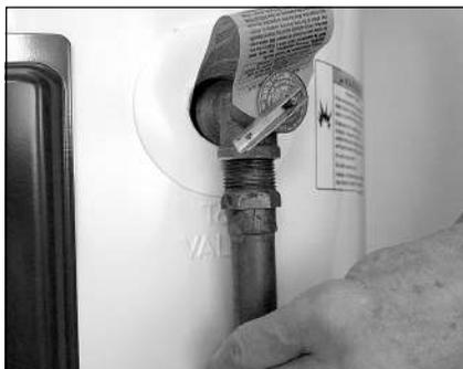
Figure 12 - Le tuyau d'évacuation de la soupape de décharge DST doit être installé correctement et canalisé à un drain adéquat.
