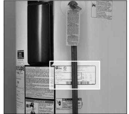
Figure 18 - Les exigences électriques du chauffe-eau peuvent être déterminées à partir de la plaque signalétique.
