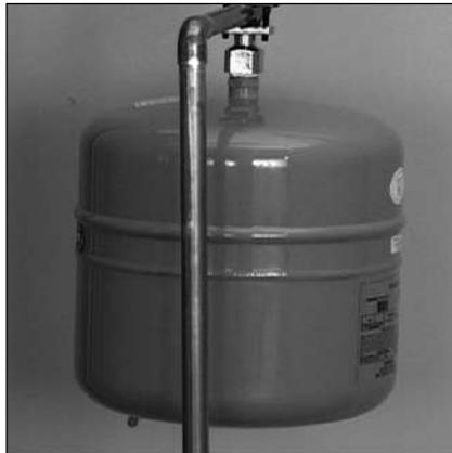
Figure 16 - Le réservoir de dilatation thermique devrait être pressurisé avec de l'air, pour correspondre à la pression d'entrée d'eau du domicile.
