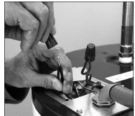
Figure 19 - Connecter les fils électriques.
