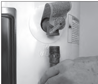
Figure 11 - Dépose du tuyau d'écoulement de la soupape DST.
