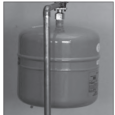
Figure 5 - Le vase d'expansion protège le circuit de plomberie contre les pointes de pression.
