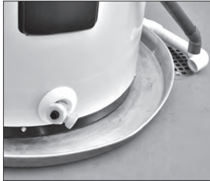
Figure 6 - Un bac collecteur adapté raccordé par un tuyau à un écoulement approprié peut permettre de protéger le plancher des fuites et égouttements.
