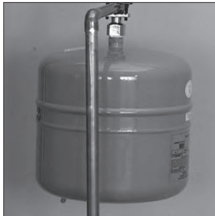
Figure 16 - Le vase d'expansion doit être pressurisé à l'air à une pression égale à celle de l'arrivée d'eau.
