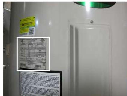
Figure 22 - Les exigences électriques du chauffe-eau peuvent être déterminées à partir de la plaque signalétique.
