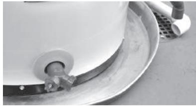
Figure 8 - Un bac de vidange approprié canalisé à un drain adéquat peut aider à protéger le plancher des fuites et des égouttements.
