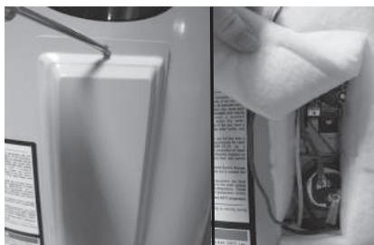
Figure 44 - Panneau d'accès à l'élément/ Compartiment ECO
