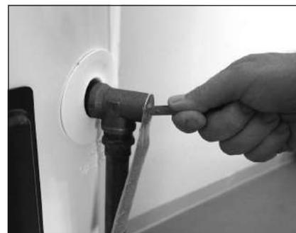
Figure 45 - Soupape de décharge à sécurité thermique
