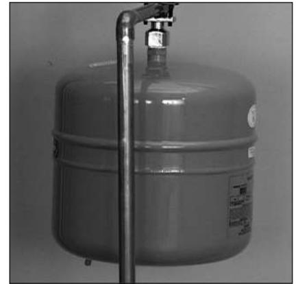
Figure 19 - Le réservoir de dilatation thermique devrait être pressurisé avec de l'air, pour correspondre à la pression d'entrée d'eau du domicile.
